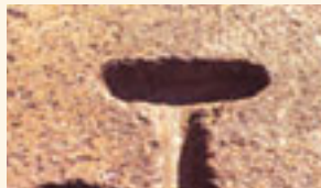
Abdrücke von Metallklammern an den Blöcken von Ollantaytambo
