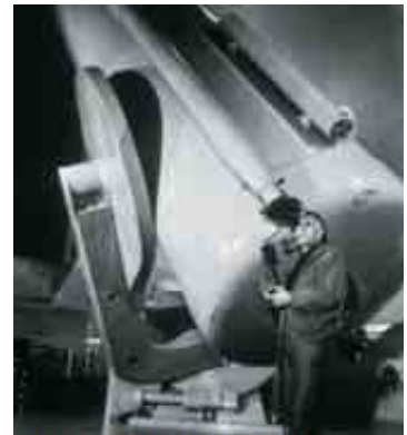
Edwin Həbl istifadə etdiyi nəhəng teleskopun yanında
